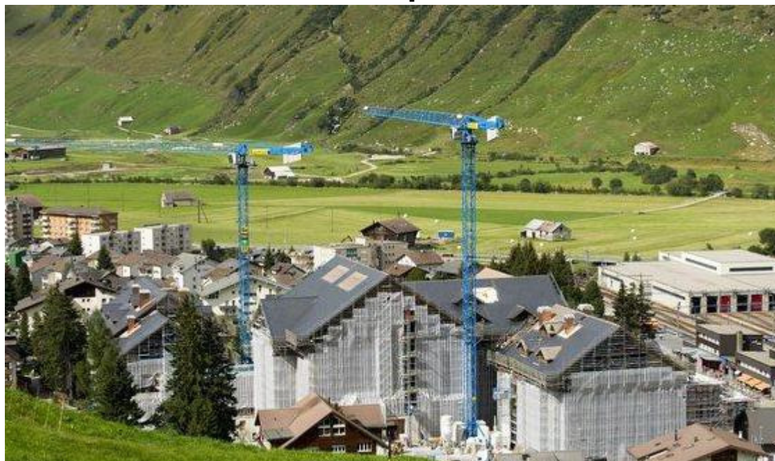
Baustelle des Hotels Chedi in Andermatt Ende August. (Bild: Keystone/Sigi Tischler)
